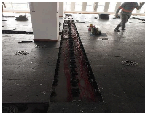
Anexo 06 – lançamento cabos CAT6
