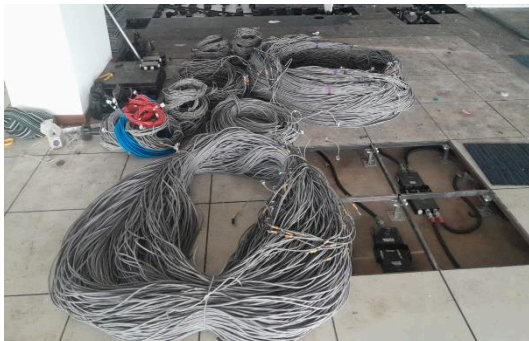
Anexo 01 – Retirada cabos CAT6.
