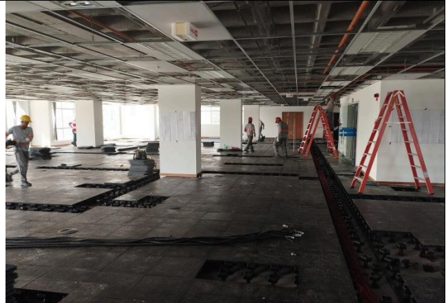
Foto 8: Torre 01 – 3º Pavimento: Instalação dos cabeios de lógica.
