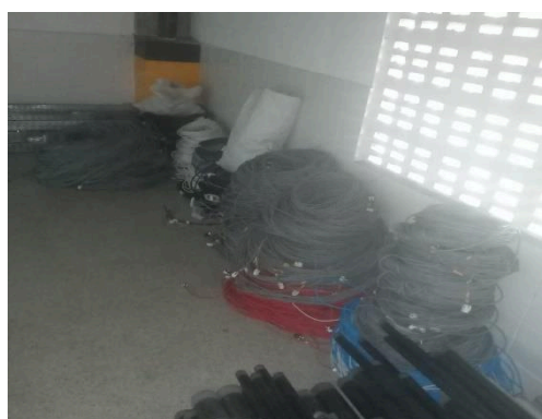
Anexo 04 – Armazenamento cabos CAT6 em almoxarifado em almoxarifado.
