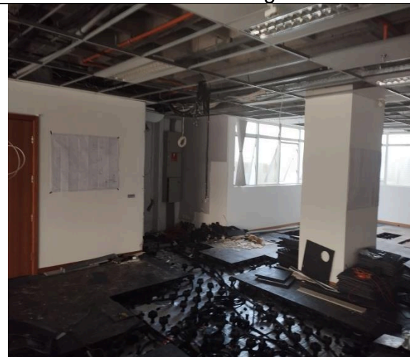
Foto 4: Torre 01 – 1º Pavimento – Cabeamento antigo retirado.
