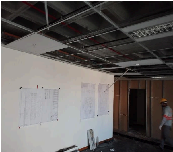
Foto 13: Torre 01 – 3º Pavimento – Execução de infraestrutura do SDAI.
