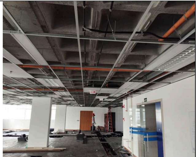
Foto 10: Torre 01 – 3º Pavimento – Instalação das infraestruturas de CFTV.
