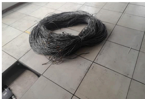
Anexo 02 – Retirada cabos CAT6.
