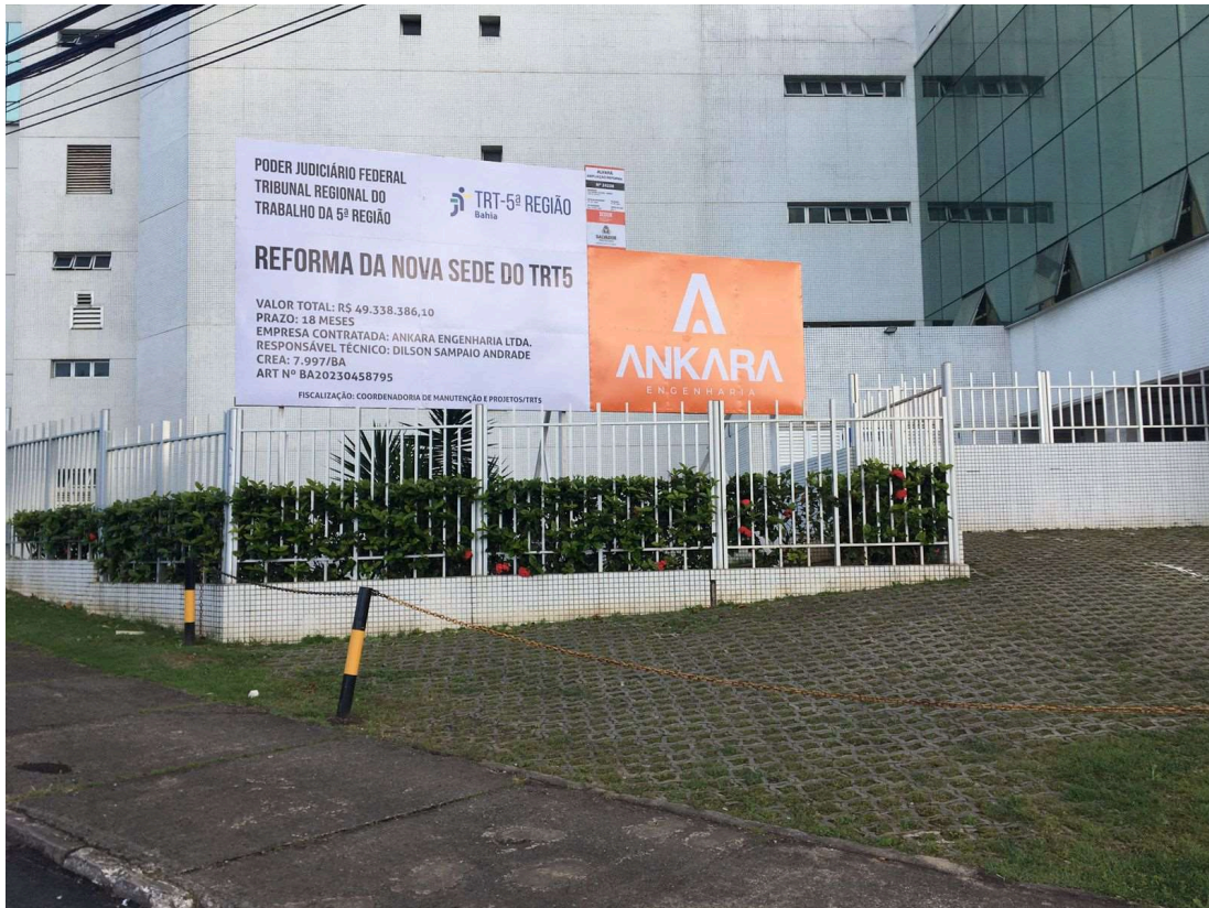
Figura 9 – Instalação das placas da obra
