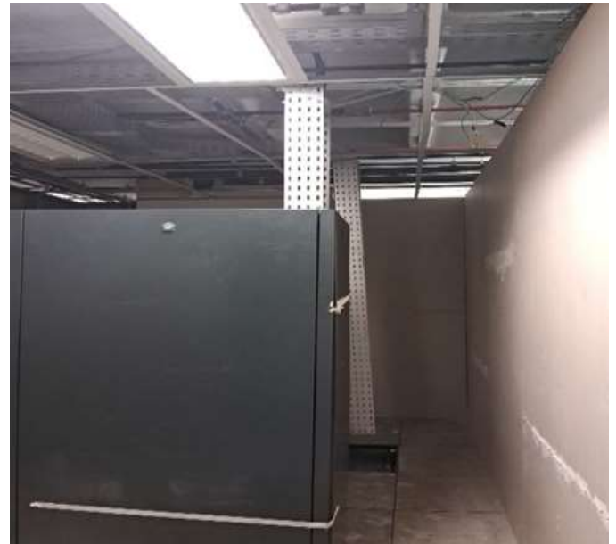
Foto 4: Torre 01 – 1º Pavimento – Entrada Superior do Rack
